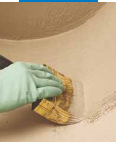
Impermeabilización de muro de cimentación a brocha
