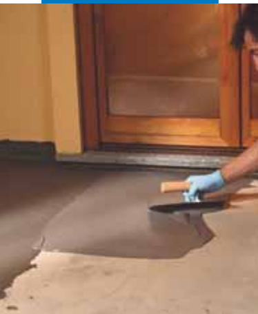
Impermeabilización de arqueta de hormigón a brocha
